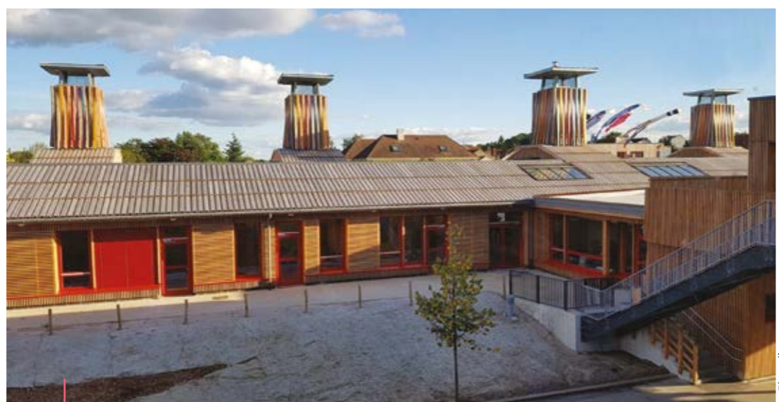
Ecole des Boutours à Rosny-sous-Bois (93) - Réhabilitation
